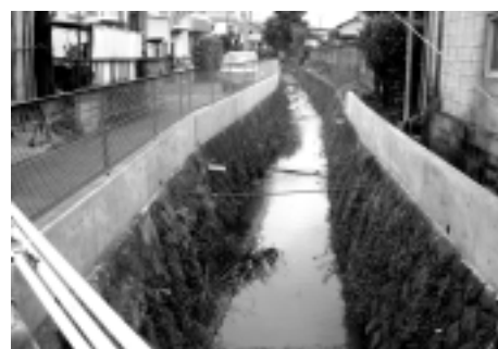
下菊川支流の両側に漏水防止壁
