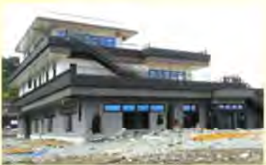
昨年7月台風12号の被害を受けた小田原漁港交流促進施設
