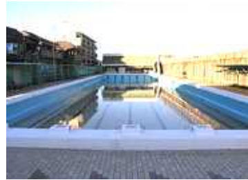
「不要」となった御幸の浜プール
