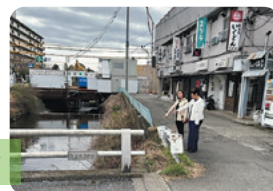
久野川護岸整備
